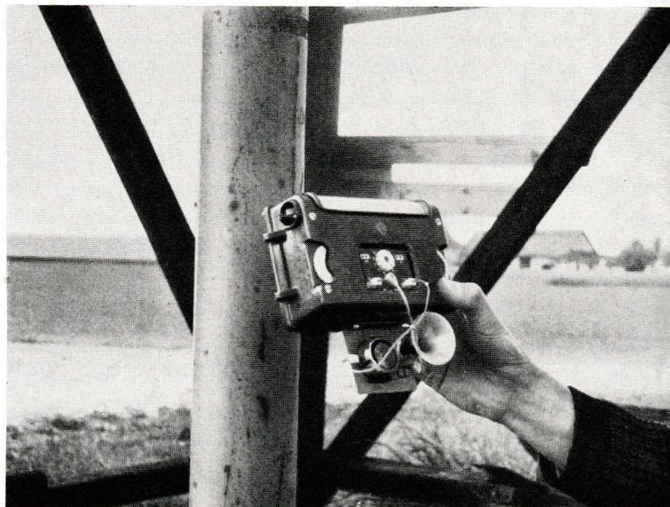
Bild 20: Abtastung von Rückstrahlern mittels eines Kleinpeilgerätes
