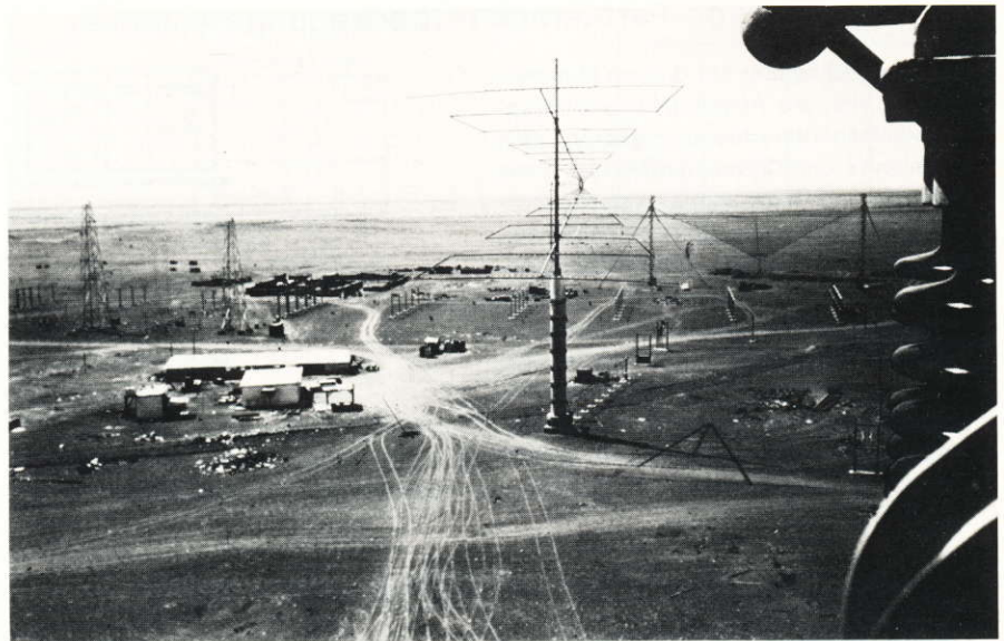
BILD 1 Drehbare logarithmisch-periodische Antenne AK 226/4471/300 für 5 bis 21,6 MHz. Foto 20 725/5
