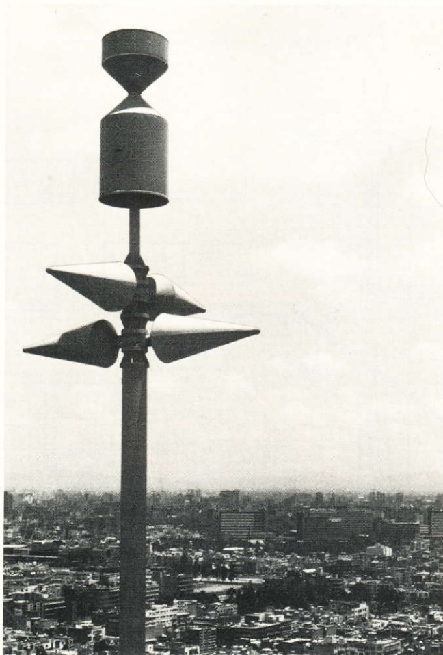
BILD 2 Breitband-Empfangs- Antennenanlage AU 74/73/80 auf dem Dach der Neben- station Mexico City. Foto: R. Wolf
