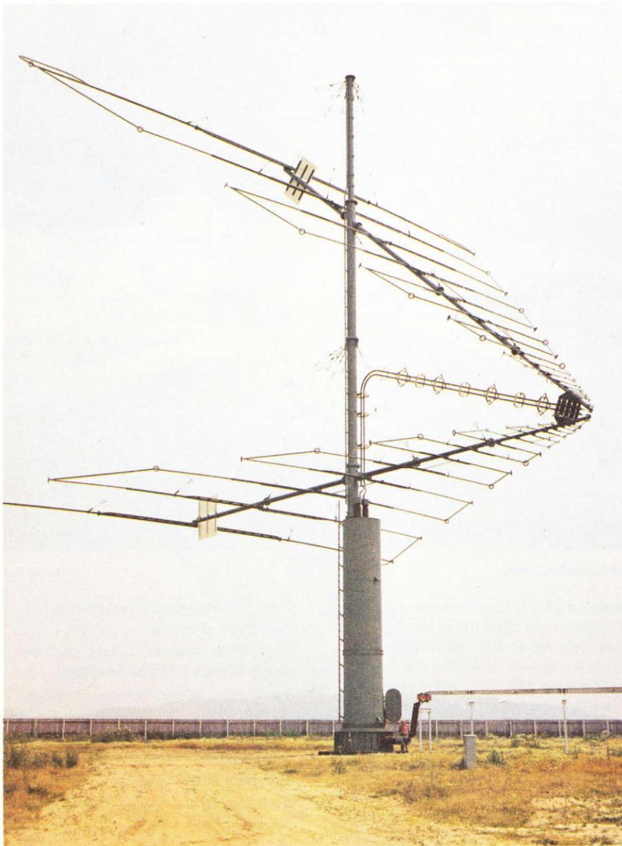
BILD 1 Logarithmisch-periodische Sendeantennenanlage AK 226/4472/180 in Jülich.
